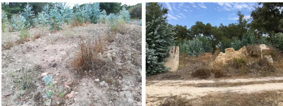
FIGURA .91 RUÍNA NAS IMEDIAÇÕES DA PARCELA 10
