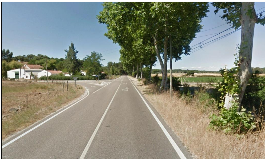
FIGURA .85 PERSPETIVA DA EN244, PARA NORTE, SOBRE O CAMINHO MUNICIPAL A POENTE FONTE FOTOGRAFIAS DOS AUTORES
