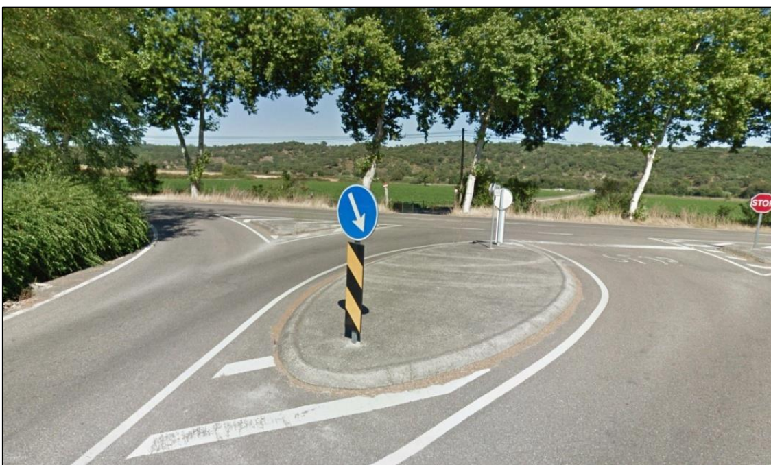
FIGURA .84 INTERCEÇÃO DO CM SOBRE A EN244, PERSPETIVA PARA NORTE FONTE FOTOGRAFIAS DOS AUTORES
